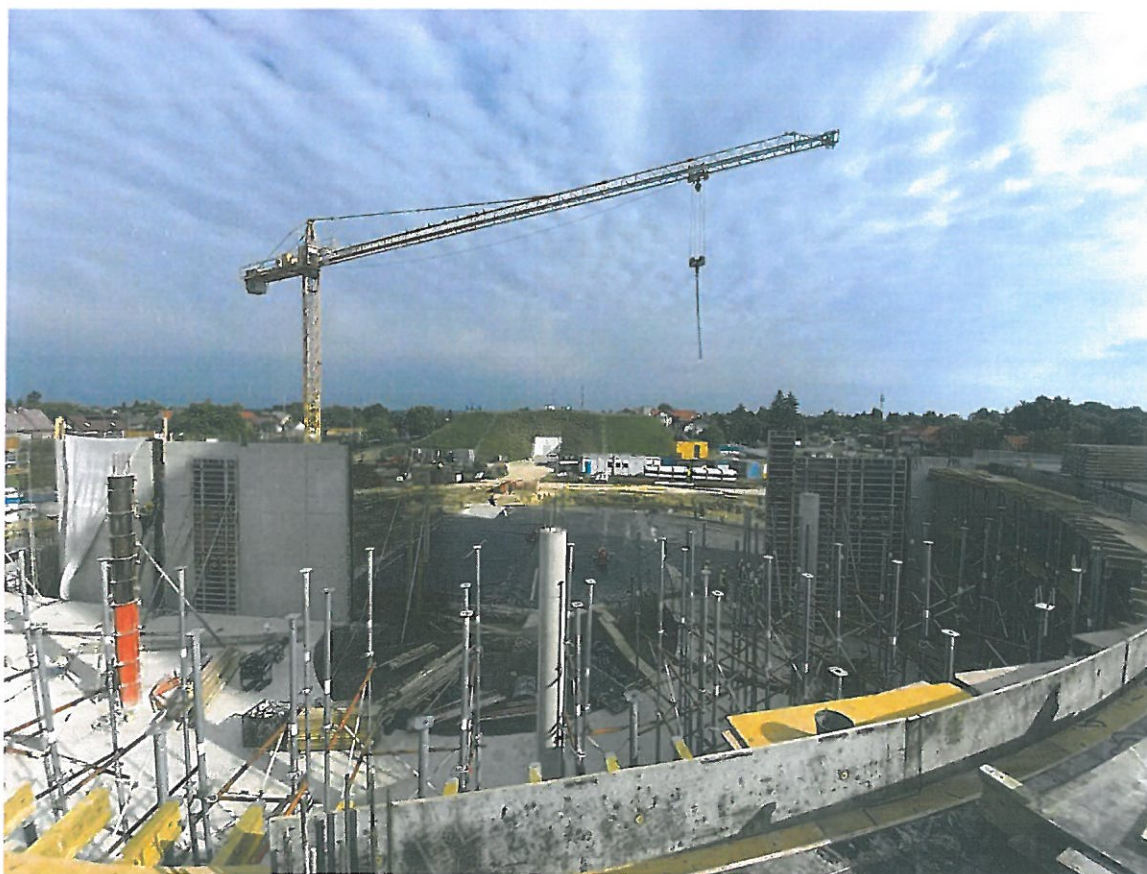
Rozbudowa zbiorników wody pitnej na os. Pobitno w Rzeszowie
